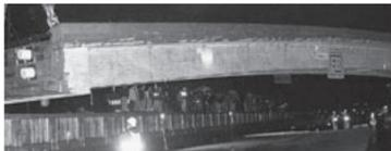
**27. Oktober 2000:** Die zwei grössten Raupenkrane der Schweiz setzen die fertige 345 Tonnen schwere Böschachbrücke über die Autobahn zentimetergenau ein.
