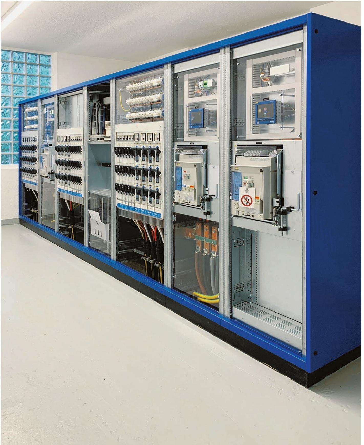
Sanierung Trafostation 03 Rohner, neue Niederspannungsverteilung (NSV)
