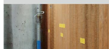
In den Liftschächten wurden probeweise Muster für das Treppenhaus angebracht – mit unterschiedlichen Einfärbungen und Strukturen.
