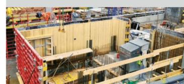
Als «knifflig» hat sich die Schalung des Haupttreppenhauses erwiesen, das in farbigem Beton ausgeführt wird.
