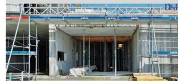
Der Eingang zum Alterszentrum führt zum öffentlichen Bistro, zum Mehrzweckraum, zur Drehscheibe, zu den Spitex-Räumen und zur Tages- und Nachtstätte. Die Decken über dem Erdgeschoss sind alle schon fertig betoniert.
