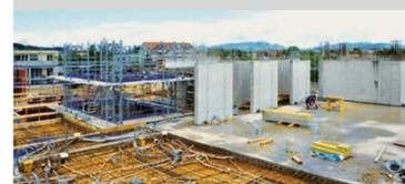
In Toiletappen betonierte sind die Decken über dem 1. und 2. Obergeschoss und die Wände im 3. Obergeschoss.
