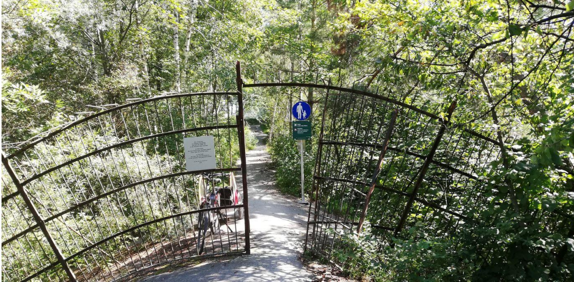
Der Stahlzaun und die Gedenktafel beim Rohr.
